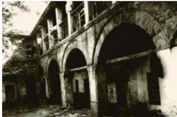
Şekil 12. Kadirga Sokollu Mehmed Paşa Külliyesi’ndeki tekke – batı kanadındaki avludan görünüm (İBB, Encümen Arşivi, 1935 istanbultarihi.ist/319-istanbul-tekkeleri)
